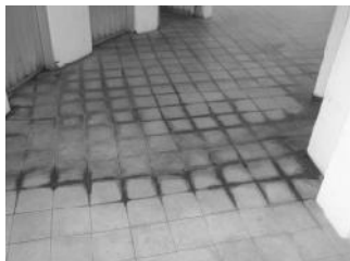
Gambar 18. Lantai toilet (Sumber: Hasil dokumentasi, 2010)
