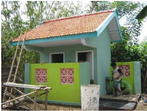
Gambar 3. KM/WC ini terletak pada bagian belakang rumah yang dirawat dan ditata bersih
