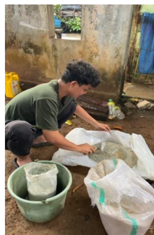
Gambar 5. Penyampuran Pasir dan Semen.
