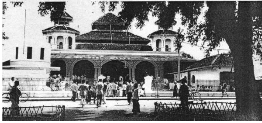
Gambar 4. Masjid Jami' dibangun dengan atap tumpang tiga dan diperluas di bagian barat dengan atap tumpang dua (1850-1853). (Sumber: van Schaik)
