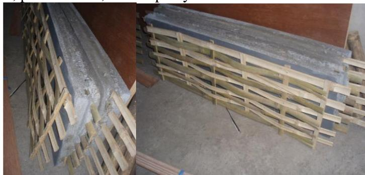
Gambar 3. Konstruksi Dinding Bambu Anyaman
