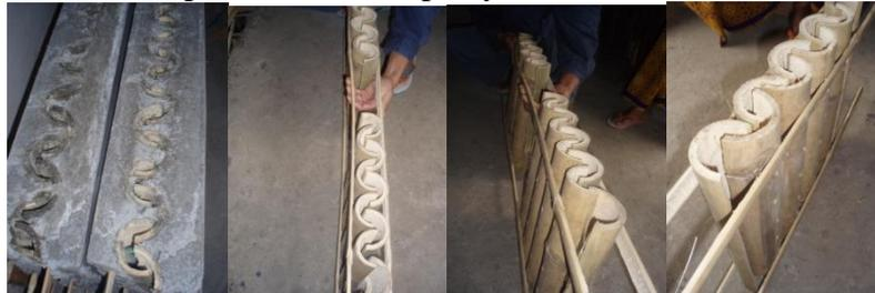
Gambar 2. Konstruksi Dinding Bambu Vertikal
