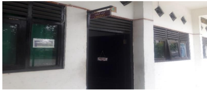
Gambar 3: Ruang Perpustakaan STIQSI Sumber : Kholili (2022)
