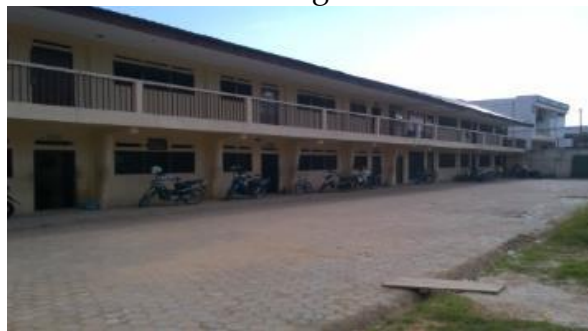
Gambar B. 6 Kondisi Bangunan MIS Al Ashriyah
